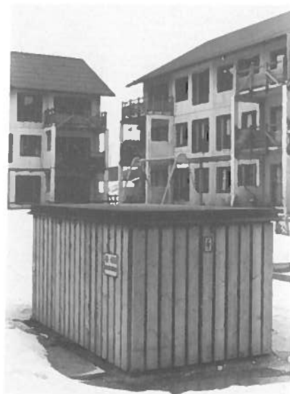
Sådan kan en transformatorstation se ud i vore dage.
